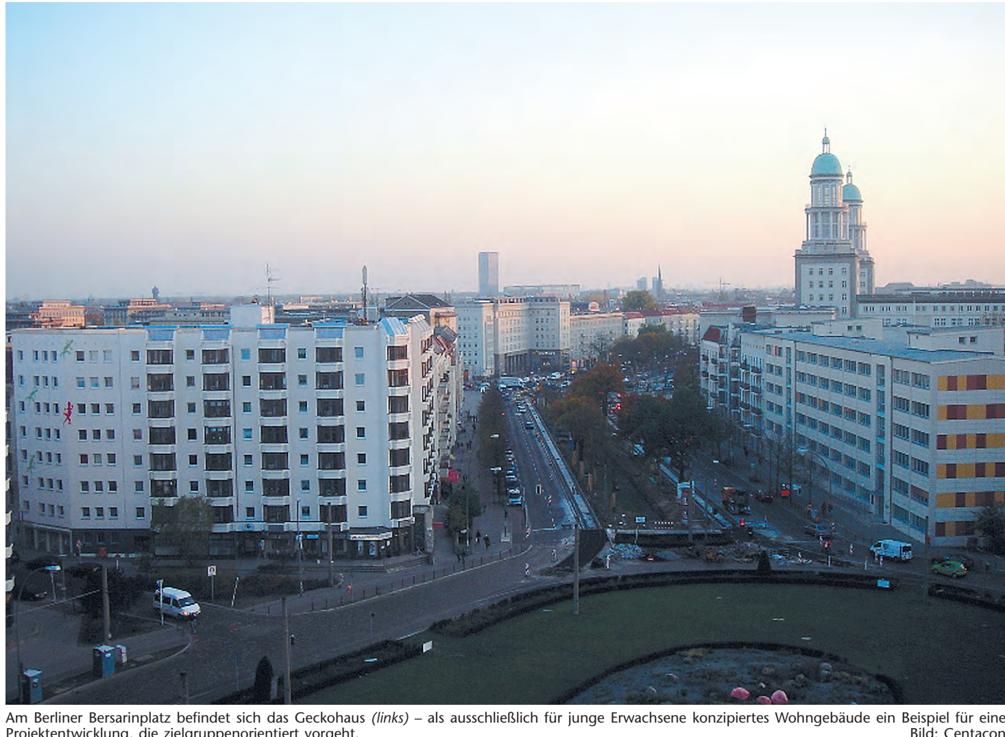
Am Berliner Bersarinplatz befindet sich das Geckohaus (links) – als ausschließlich für junge Erwachsene konzipiertes Wohngebäude ein Beispiel für eine Projektentwicklung, die zielgruppenorientiert vorgeht. Bild: Centacon
